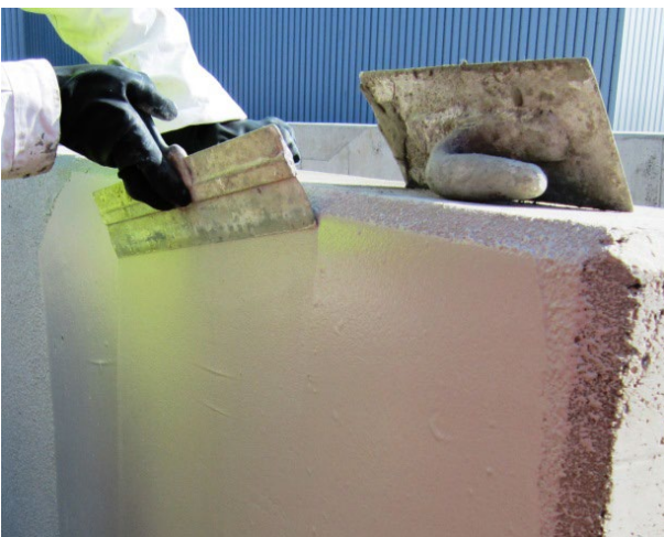
Obr.2.: Aplikace / vyhlazení povrchu MasterSeal 6100 FX pomocí hladítka
