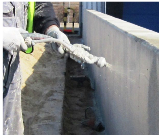
Obr.2.: Aplikace MasterSeal 6100 FX nástřikem
