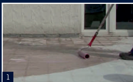
Důkladné očištění a penetrace podkladu, např. nátěrem D11.
