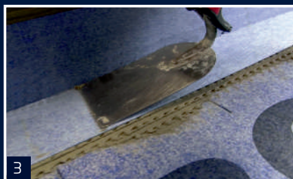
Překlenutí koutů, dilatačních spár provést systémovým pásem SB78 a příslušenstvím.
