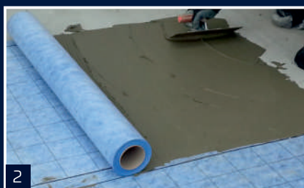
Hydroizolační fólie AE se ukládá s překrytím 5 cm do lepicího lože tmelu M21 HP Speed.
